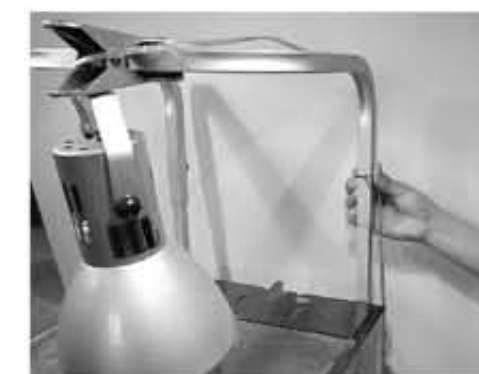
17.照明装置の取り付け
